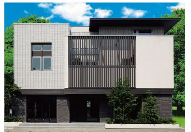
CENTURY 3階 蔵 木質パネル接着工法
